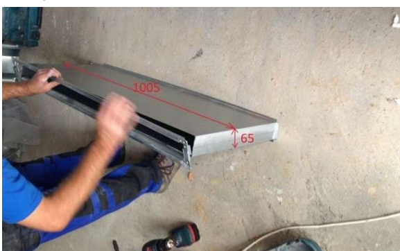
5. Montage der Abdeckung des Luftentfeuchters 6. Kürzen Sie das Rohr entsprechend der Wandstärke - schneiden Sie von der Flanschseite aus
