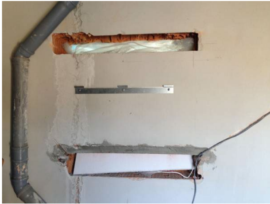
3. Montage der Halterung an der Wand 4. Montage des Luftentfeuchters und Verkabelung elektrisches Kabel und Kondensatablauf
