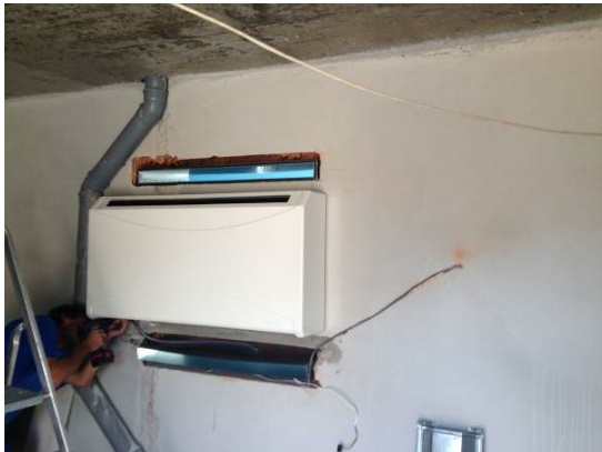
5. Montage der Abdeckung des Luftentfeuchters 6. Kürzen Sie das Rohr entsprechend der Wandstärke - schneiden Sie von der Flanschseite aus
