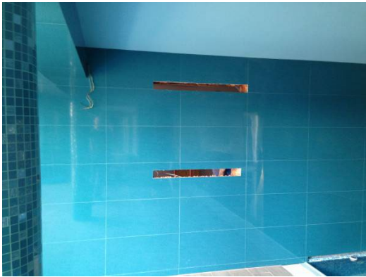
1. Schneiden von Übergängen in der Wand 2. Messen der Konsole mit Hilfe der Schablone
