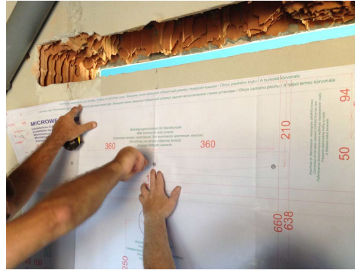
1. Schneiden von Übergängen in der Wand 2. Messen der Konsole mit Hilfe der Schablone
