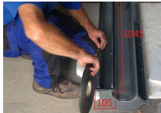
5. Montage der Abdeckung des Luftentfeuchters 6. Kürzen Sie das Rohr entsprechend der Wandstärke - schneiden Sie von der Flanschseite aus
