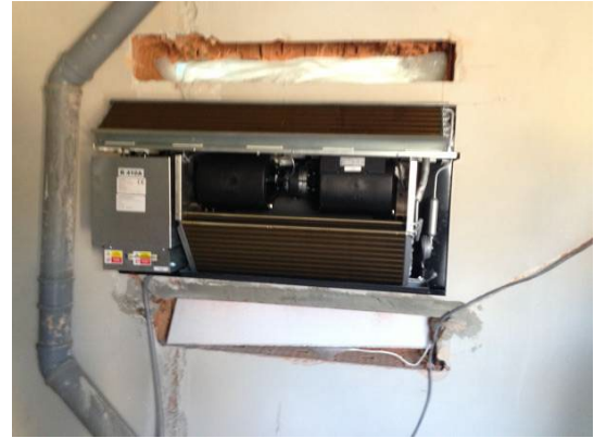
3. Montage der Halterung an der Wand 4. Montage des Luftentfeuchters und Verkabelung elektrisches Kabel und Kondensatablauf
