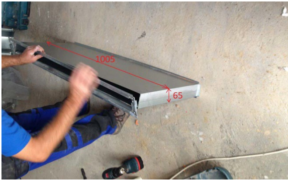
7. Remachado de la brida al tubo acortado
