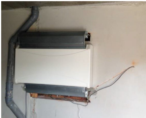
9. Montaje de tubería en la tapa
