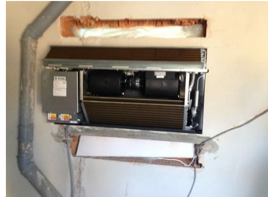
4. Instalación del deshumidificador y cable eléctrico y desagüe de condensados
