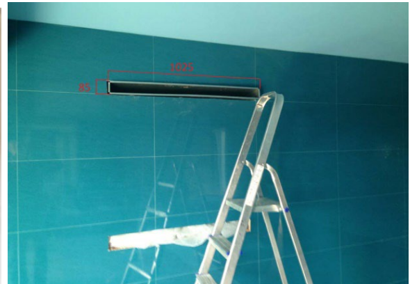
10. Instalación de tuberías con la superficie final de la sala de billar
