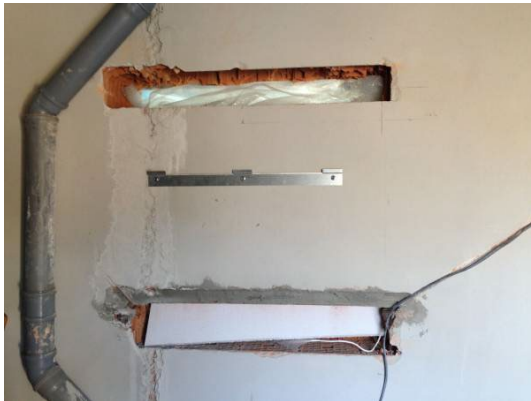
3. Montaje de consola de pared conexión del
