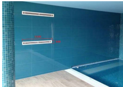
12. Montaje de parrillas
