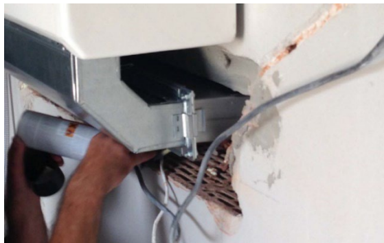
11. Sellado de huecos en la pared con espuma PUR
