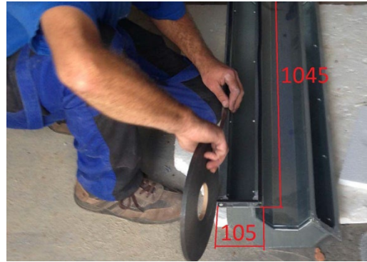
8. Pegado del sello a las juntas de la tubería
