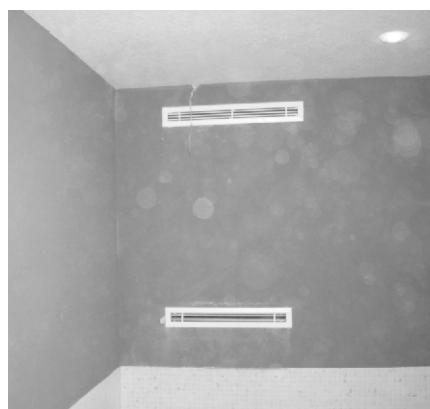
Pohled z bazénové haly
