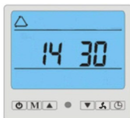
Obrázok: Kontrola parametrov, vstupná teplota vody je 30°C.
