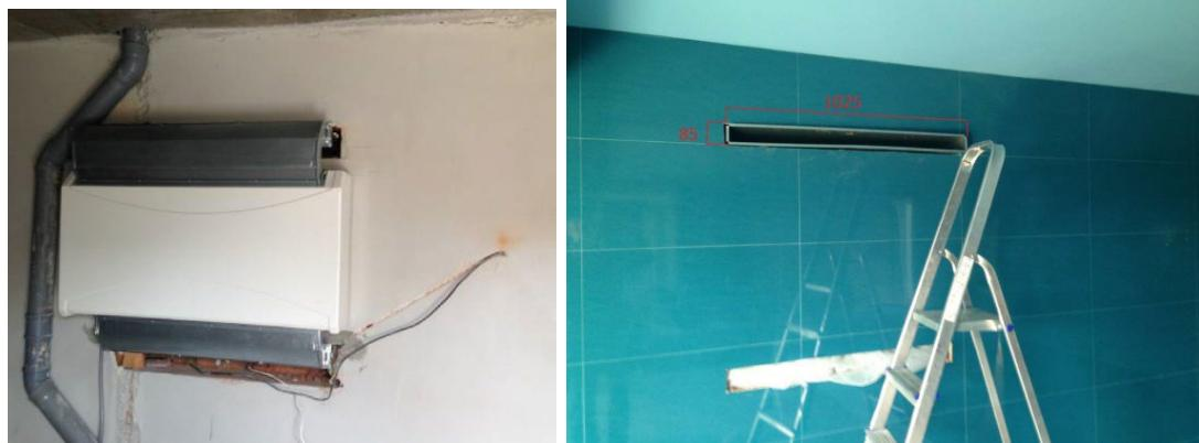
9. Namontovanie potrubí na kryt 10. Namontovanie potrubia zarovno s finálnym povrhom steny v bazénovej hale
